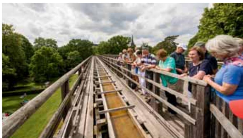
Fünf Gradierbauten, die zu den ältesten ihrer Art in Deutschland zählen, sorgen auf 650 Metern Gesamtlänge für das Verrieseln der Sole an den bis zu 10 Meter hohen Schwarzdornwänden.
